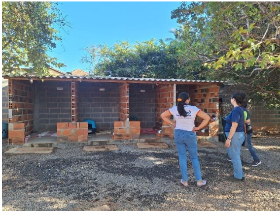
Baias em área externa Autoria: Luísa Mosqueira Data: 25/06/2024
