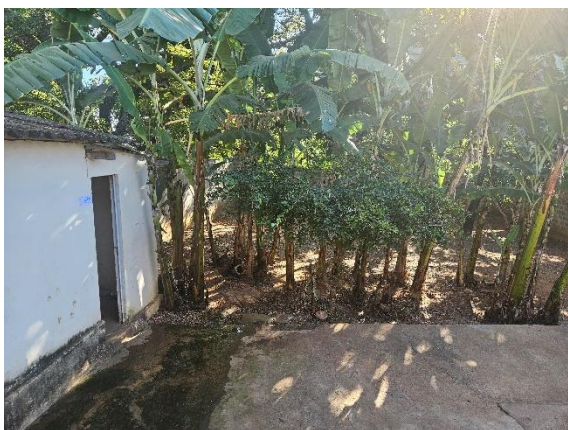
Vista geral da área externa Autoria: Carolina Rodrigues Bordignon Data: 25/06/2024
