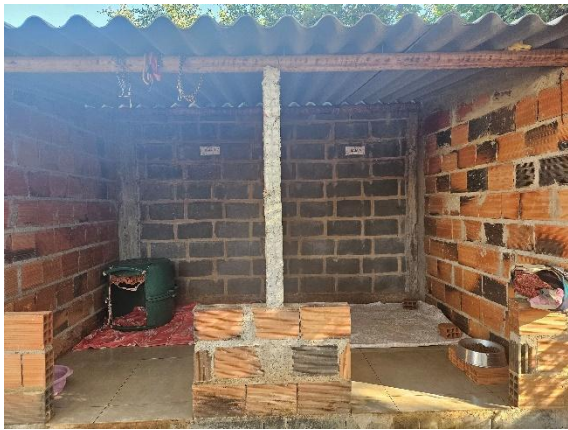
Baias em área externa Autoria: Carolina Rodrigues Bordignon Data: 25/06/2024
